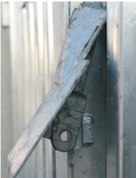
Türblatt rechts: Türverschluss außen für bauseitiges Vorhangschloss mit Abdeckblech
