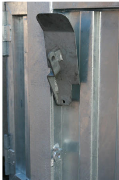
Türblatt rechts: Verschlusshebel geöffnet
