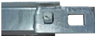
Linker Türflügel mit aufgeschweißtem Riegelblech und Verschlussstange
