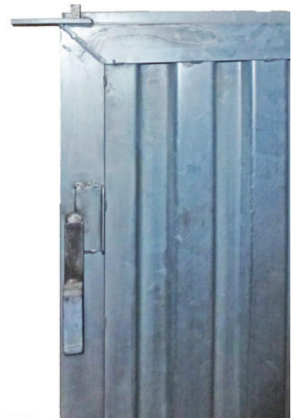
Türblatt links: Türverschluss innen mit Handriegel
